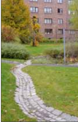
Steinsatt renne, Thorsov, Oslo.
