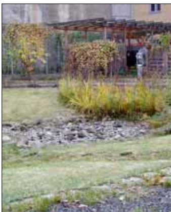
Overløpsdam, Nordbyhagen, Oslo.
